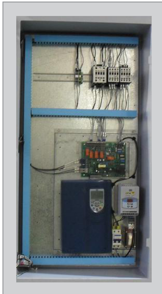
Figura 5.6 (a): Compartimento de baixa tensão - IP41
