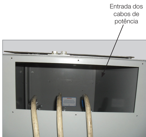
(a) Passagem dos cabos pela lateral direita do painel
