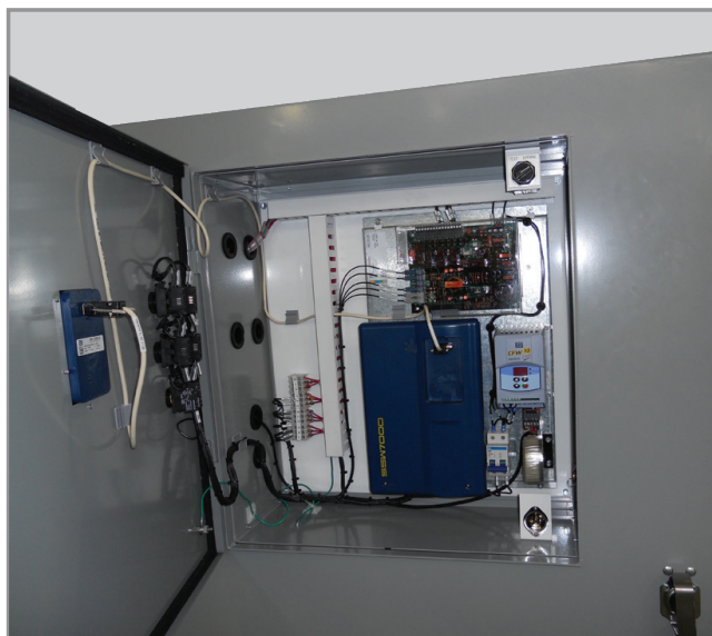
Figura 5.6 (b): Compartimento de baixa tensão - Nema 12
