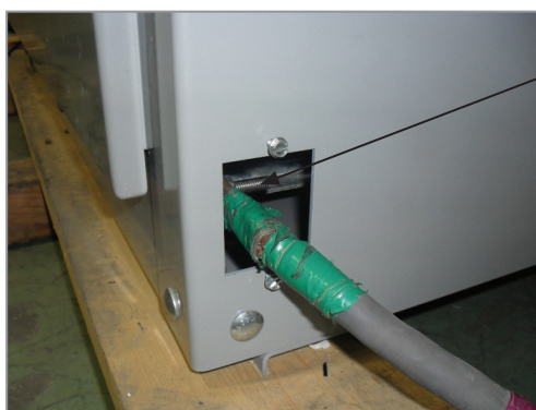
Figura 5.19 (b): Conexões de entrada de potência e aterramento - Nema 12
