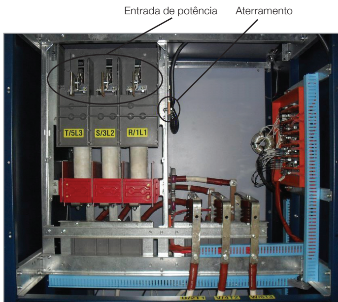
Figura 5.19 (a): Conexões de entrada de potência e aterramento - IP41
