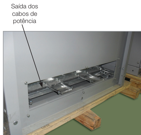
(b) Passagem dos cabos pela parte posterior do painel
