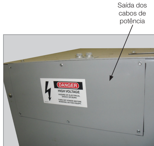
(c) Passagem dos cabos pela parte superior da lateral esquerda do painel
