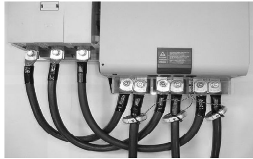
Figura 9.15 - TCs para aquisição de corrente externa
